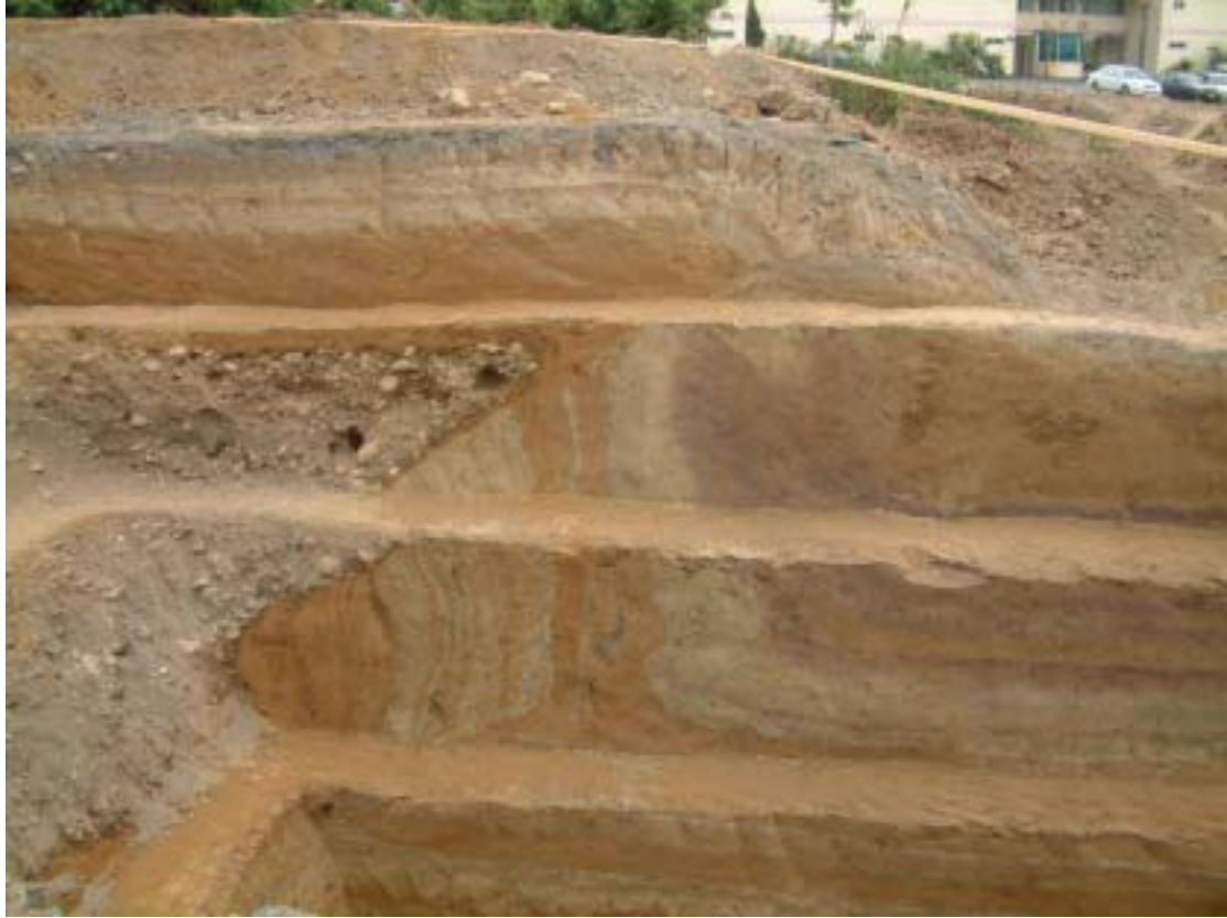
圖 3 南牆剖面的構造以斷層作用為主，位在下盤地下 8 公尺深的礫石層隨著逆斷層的上衝已經位於上盤接近地表處，斷層兩側具有 8 公尺的落差。
